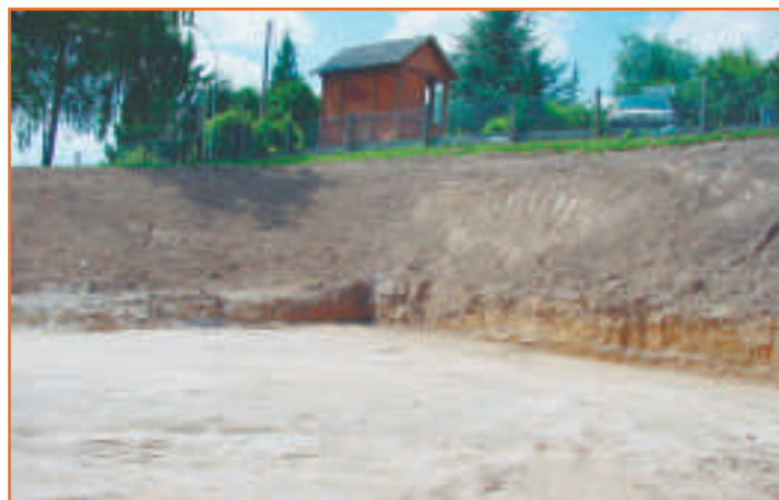
L'excavation nécessaire aux soubassements de la future cantine.
